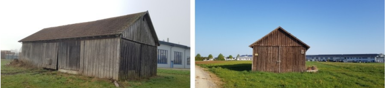
Abb 10: Schuppen auf Flurstück Nr. 522. An diesem wurden keine Einflüge von Fledermäusen festgestellt.
